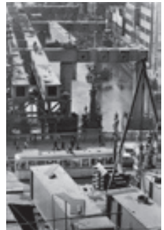
《日本橋の上をまたぐ首都高速道路を建設中》[中央区] 1963年
